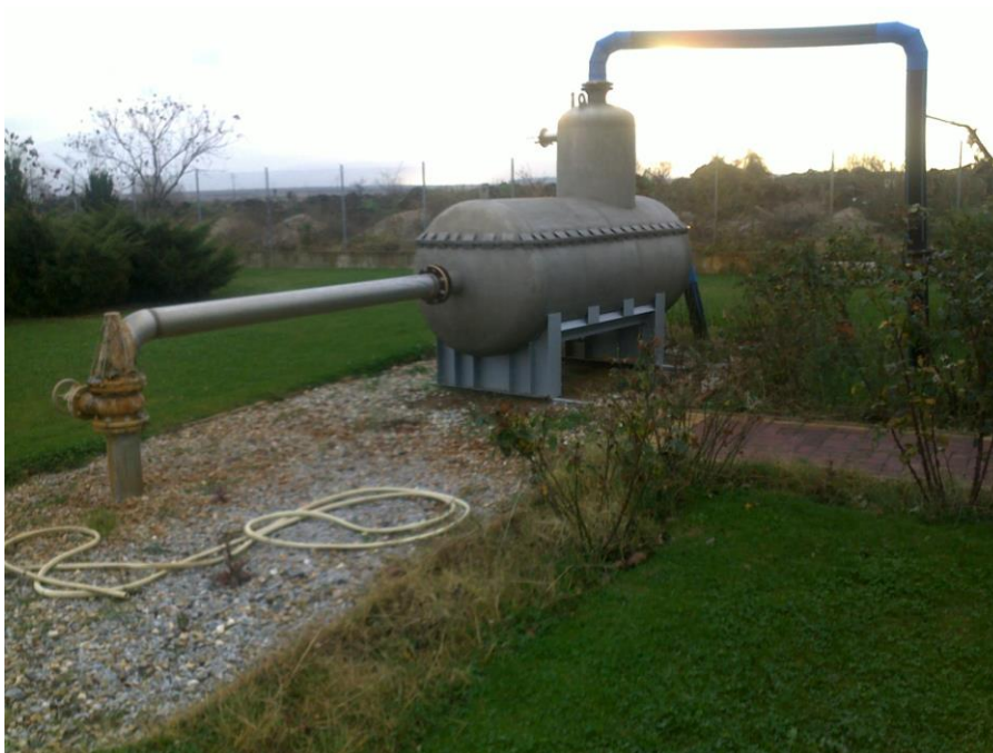
Слика бр.10 Извирање, сепарирање на суров гас од вода-DZ 3
